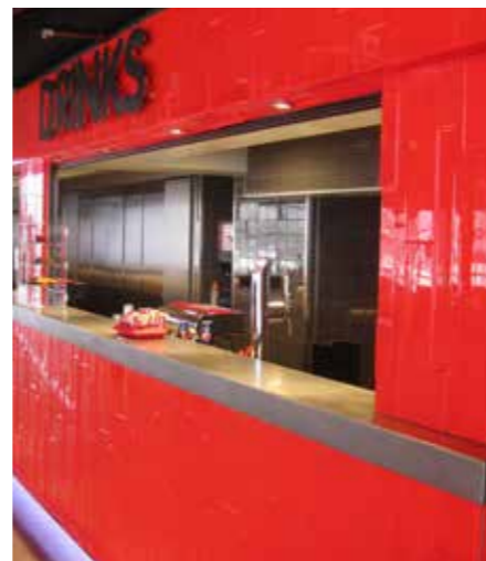
Kool - Ahoy Rotterdam - 2K epoxy coating
